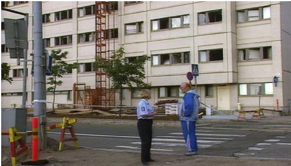
Kuva 3 Räjähdyks rikkoi kaikki Pasilankadun puoleiset ikkunat.
