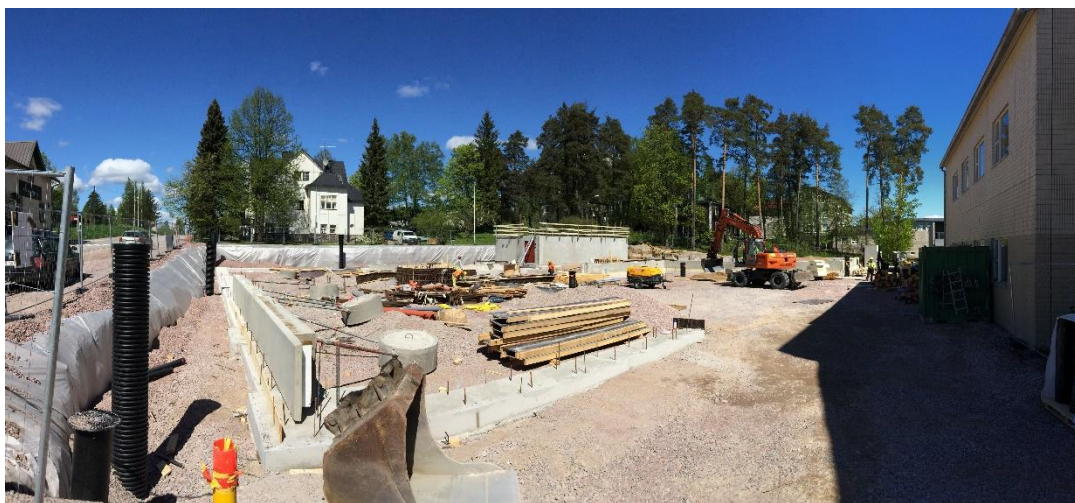
Kuva 6. Yleiskuva palvelutalon työmaasta
