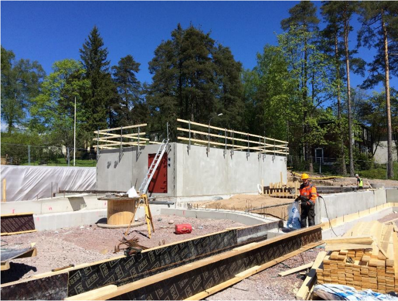
Kuva 7 ja 8. Väestönsuoja on valmis (elementti)
