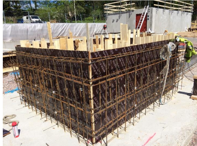
Kuva 9 ja 10. Sokkelinostojen muotti- ja raudoitustyöt ovat käynnissä.
