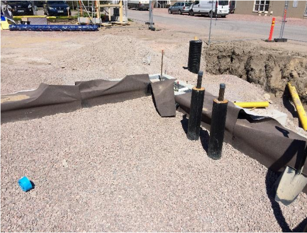
Kuva 2 ja 3. Senioritalon alapohjan radon kermit ovat asennettu ja maavaraisen laatan lämmöneristystyöt käynnissä.
