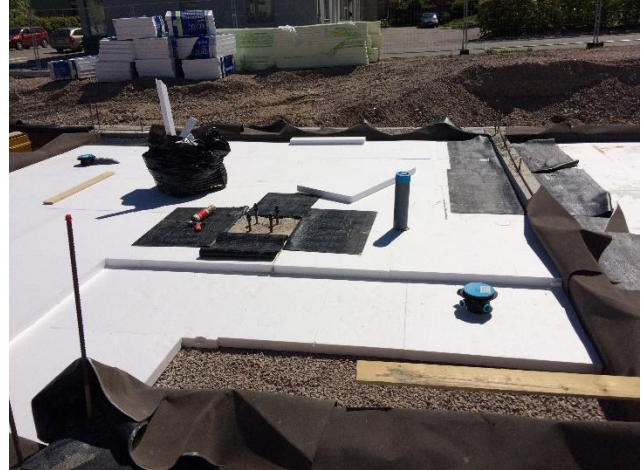
Kuva 2 ja 3. Senioritalon alapohjan radon kermit ovat asennettu ja maavaraisen laatan lämmöneristystyöt käynnissä.
