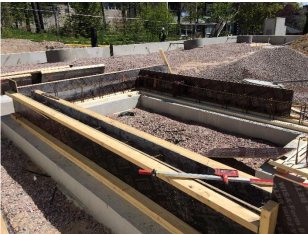
Kuva 9 ja 10. Sokkelinostojen muotti- ja raudoitustyöt ovat käynnissä.
