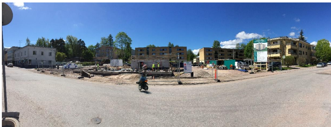
Kuva 1. Yleiskuva Senioritalon työmaasta
