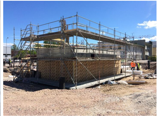
Kuva 4 ja 5. Senioritalo, väestönsuojan sisäpuoliset täyttötöet ovat alkamassa ja väestönsuojan ulkopuolisten lämmöneristystöiden asennustyöt ovat käynnissä
