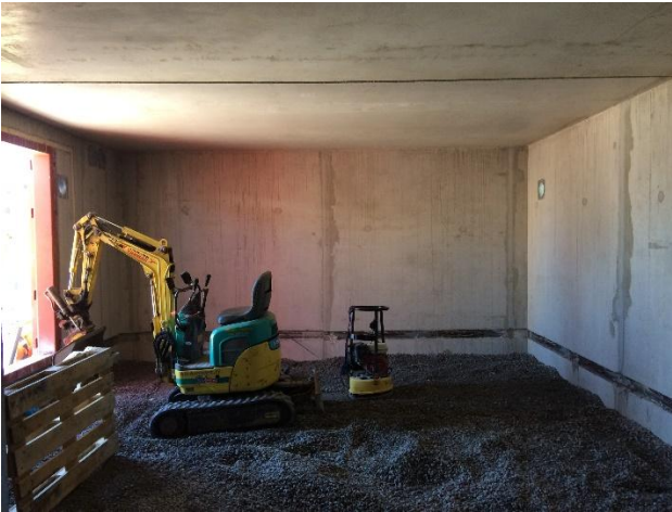
Kuva 4 ja 5. Senioritalo, väestönsuojan sisäpuoliset täyttötöet ovat alkamassa ja väestönsuojan ulkopuolisten lämmöneristystöiden asennustyöt ovat käynnissä
