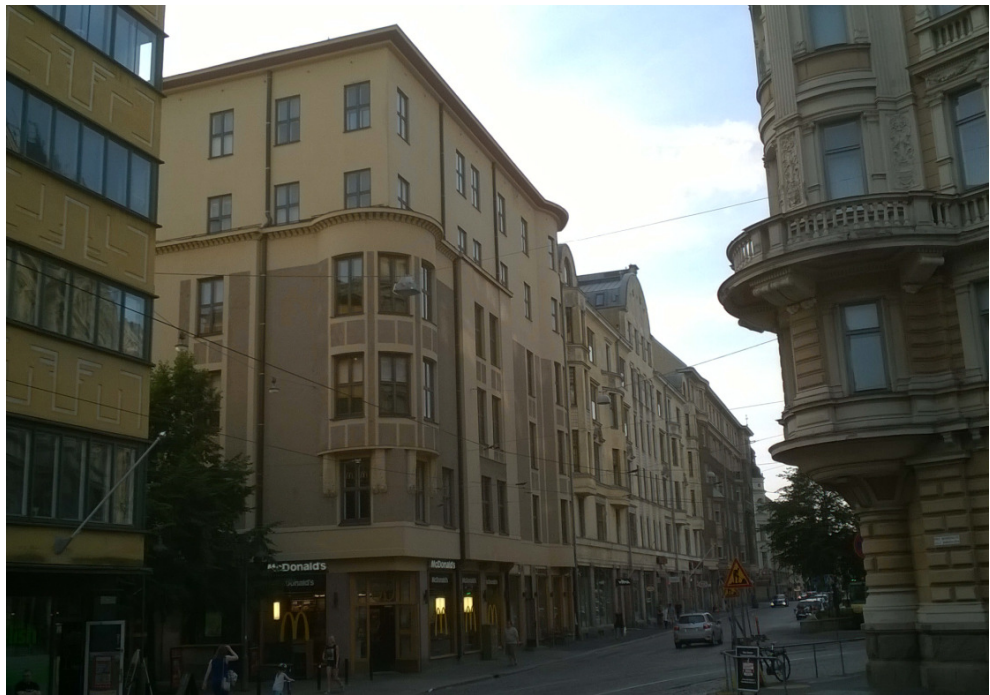
Kuva 9 Kiinteistö Oy Iso Roobertinkatu 1: näkymä Yrjönkadulta. Kuva: Risto Rautio 11.08.2015.
