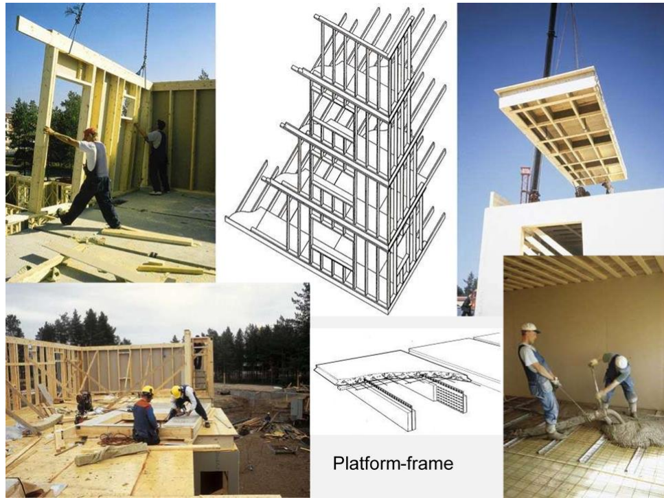
Kuva 3. Platform-tekniikalla rakentamisen kuvausta
