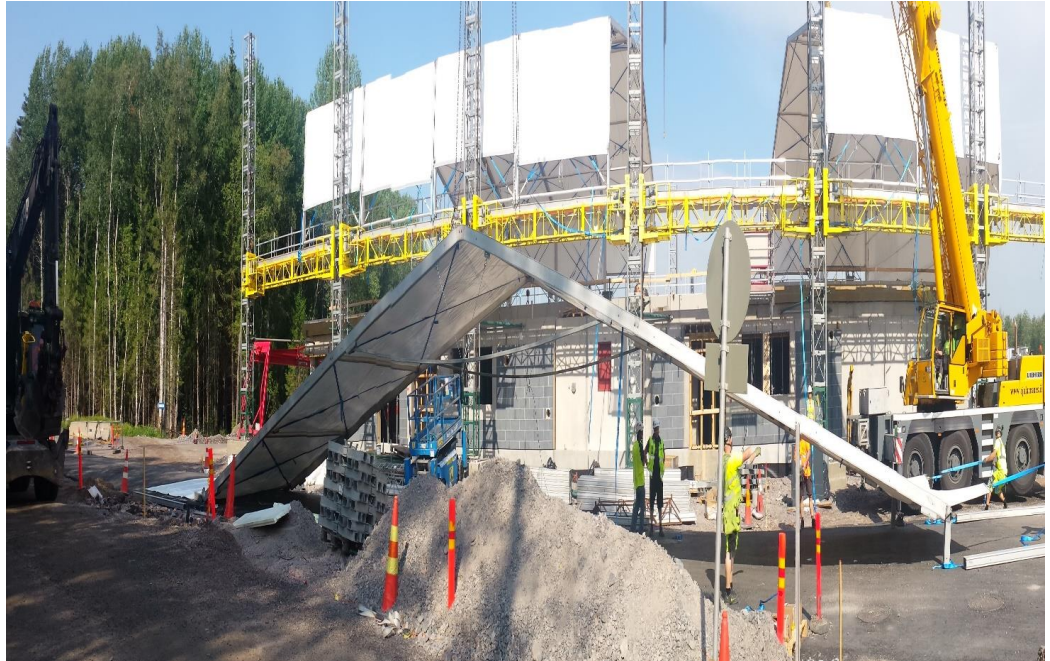
Kuva 2. Suomen Vuokratodit Oy ja TA-asumisoikeus Oy:n Vantaan asuntomessuille 2015 valmistuvan puukerrostalon työmaa. Kohde valmistuu Reposen omalla PuuMera-konseptilla
