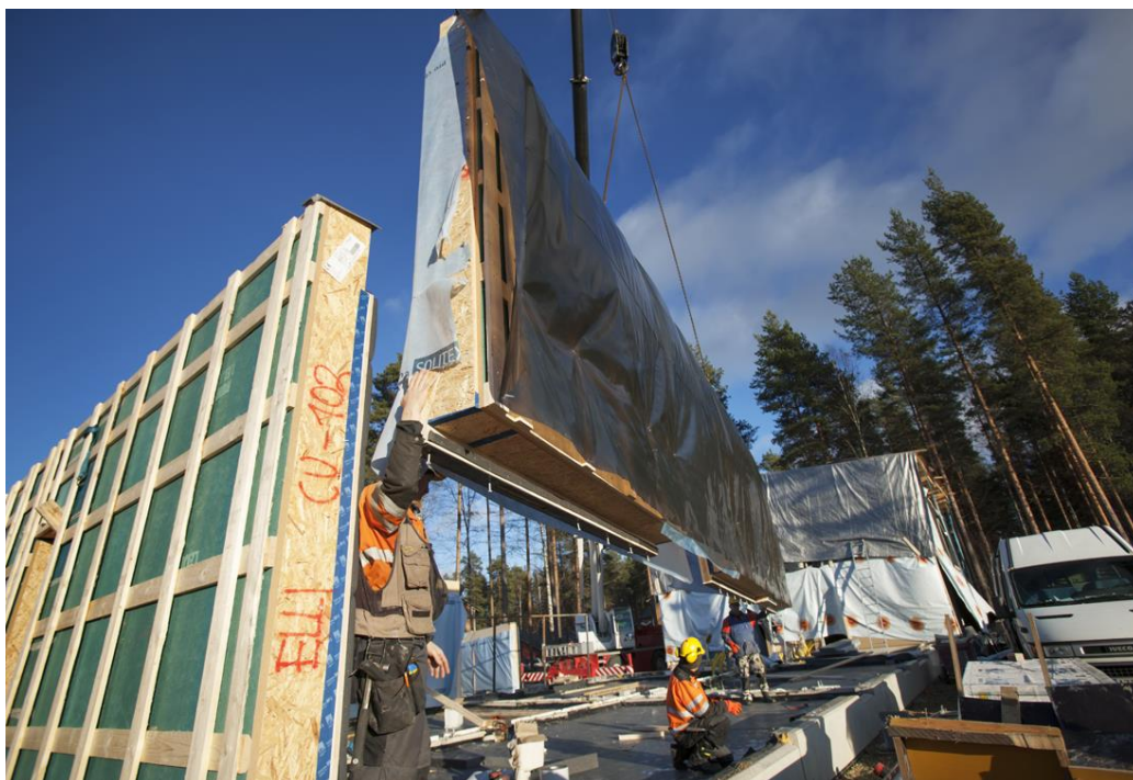
Kuva 6. Kuvassa on Oy Joensuun Ellin clt-tekniikalla rakennettu 2-kerroksinen opiskelijoiden vuokratalo. Kuvassa on meneillään clt-elementtien asennustyö. Katsoja voi huomioida sen, että elementeissä ei ole valmiina julkisivupaneelia eikä ikkunoita paikallaan kuten tilaajan ja toimitajan kesken oli sovittu.
