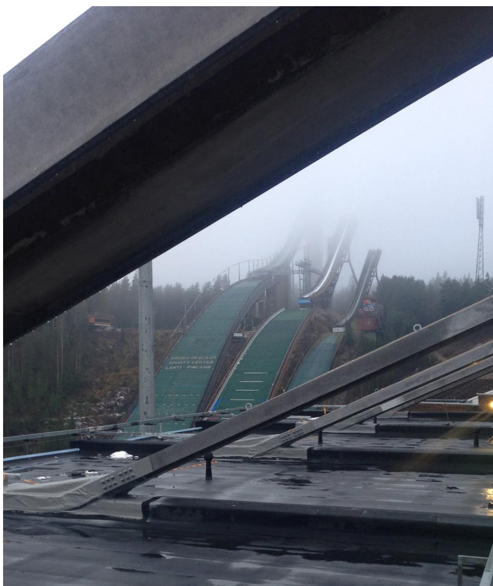
Kuva 4 Jännebetonisauvoja varmistavat teräsrakenteet asennettuina paikoilleen
