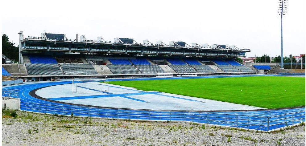
Kuva 2 Selostamotaso on ripustettu pääkatsomon ylle jännebetonirakentein
